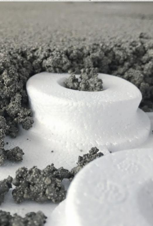
AirBase® kann direkt haftend auf Steinuntergründen verlegt werden. Der Leichtestrich kann aber auch in Kombination mit Schwalbenschwanzplatten auf einer Holzbalkenschicht oder schwimmend direkt auf Holzböden aufgebracht werden. Im Vergleich zu anderen Systemen, lassen sich bei einer schwimmenden Anwendung auf Holzkonstruktionsböden (z. B. bei einer Renovierung) viele Vorteile erzielen.
